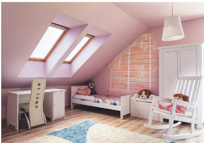
System s upínacou lištou inštalovaný ako stenové vykurovanie
