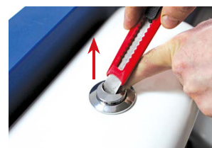
3. Skrutkovačom alebo nožom podoberieme Mesiac a ľahkým páčením ho vyberieme von. Potom aj Zem.
