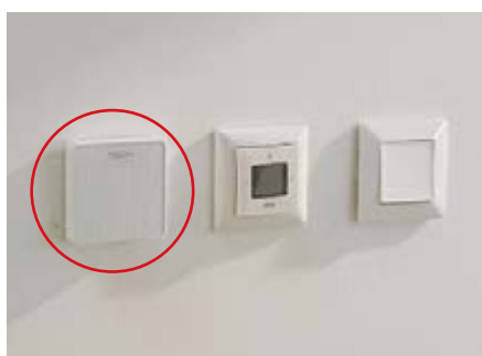
Ľavý nástenný panel: bezdrôtový snímač
