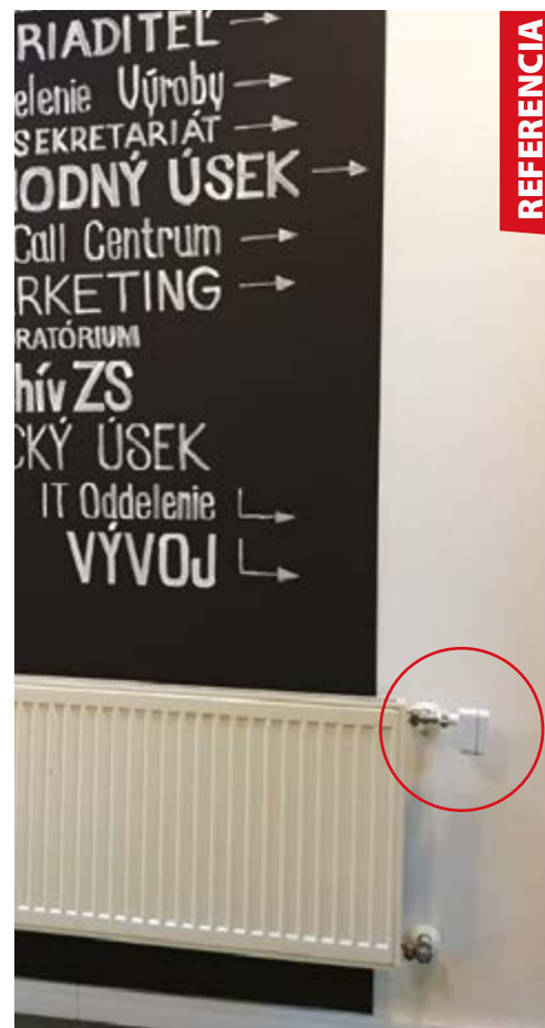
Hlavica na radiátore: bezdrôtový elektrický pohon ventila
