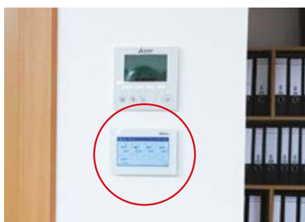
Spodný nástenný displej: bezdrôtový Wi-Fi prijímač
