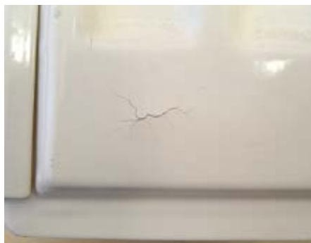
Dôsledok pôsobenia mrazu v mieste takzvaného T-spoja
